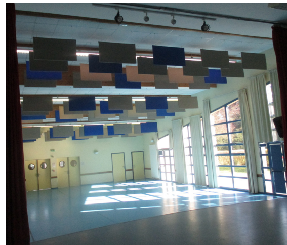
Les 84 écho-baffles absorbent les sons pour mieux les restituer.
