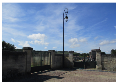
Le parking et l'entrée du cimetière, rue du Calvaire.
