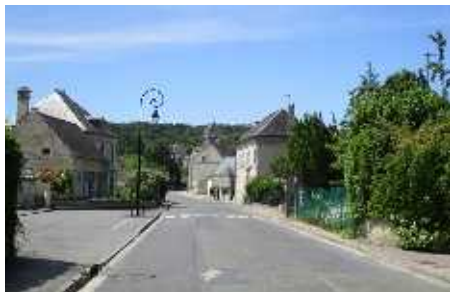
Les travaux dans la rue du Pont-Cheminet sont planifiés au printemps 2016.
