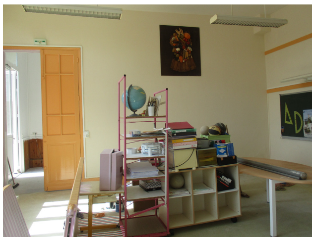
La classe de CE1-CE2 en cours de rénovation pendant l'été.
