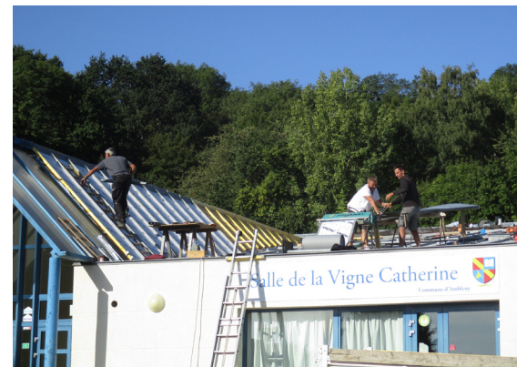
Un toit tout neuf pour la salle polyvalente.
