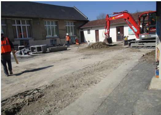
Gros chantier de réfection dans la cour de l'école élémentaire.
